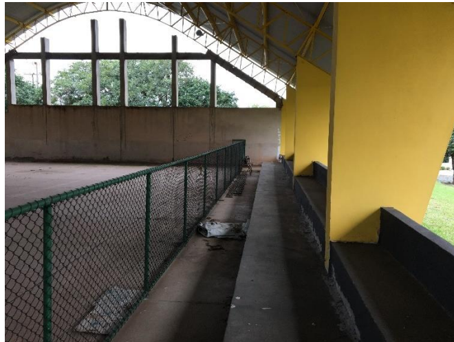
Revestimento argamassado da arquibancada
