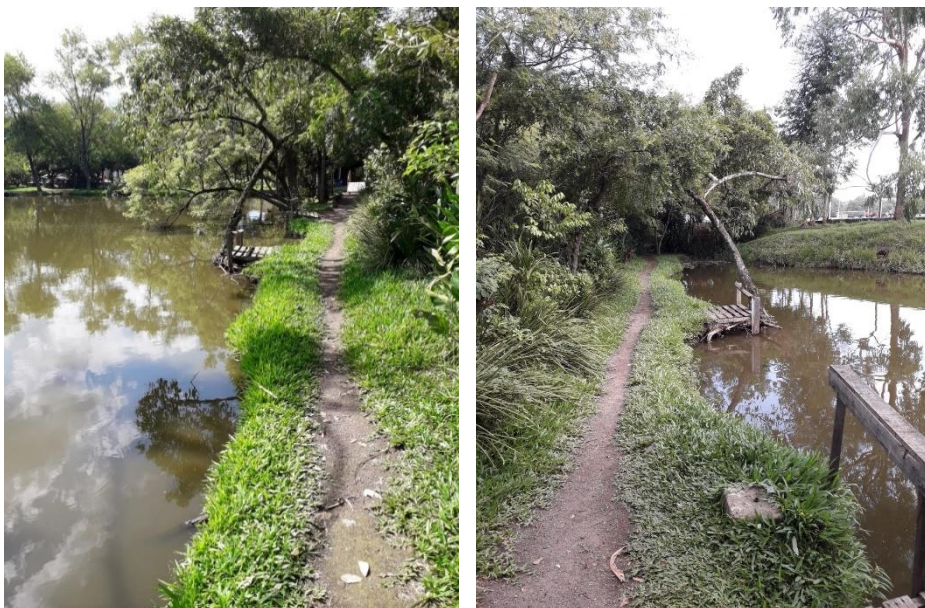
Imagens 8 e 9 – Local de intervenção: Contenção da margem do lago
